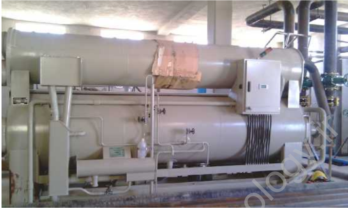
شکل ۵- نمایی کلی از چیلر جذبی نصب شده و برخی از ملحقات آن داخل سالن چیلر جذبی
